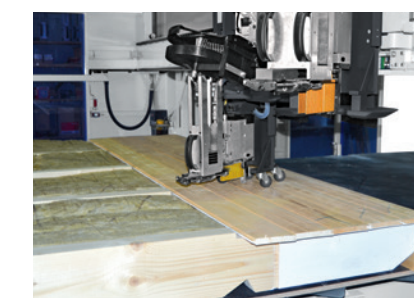
Befestigen von Schalungsbrettern
